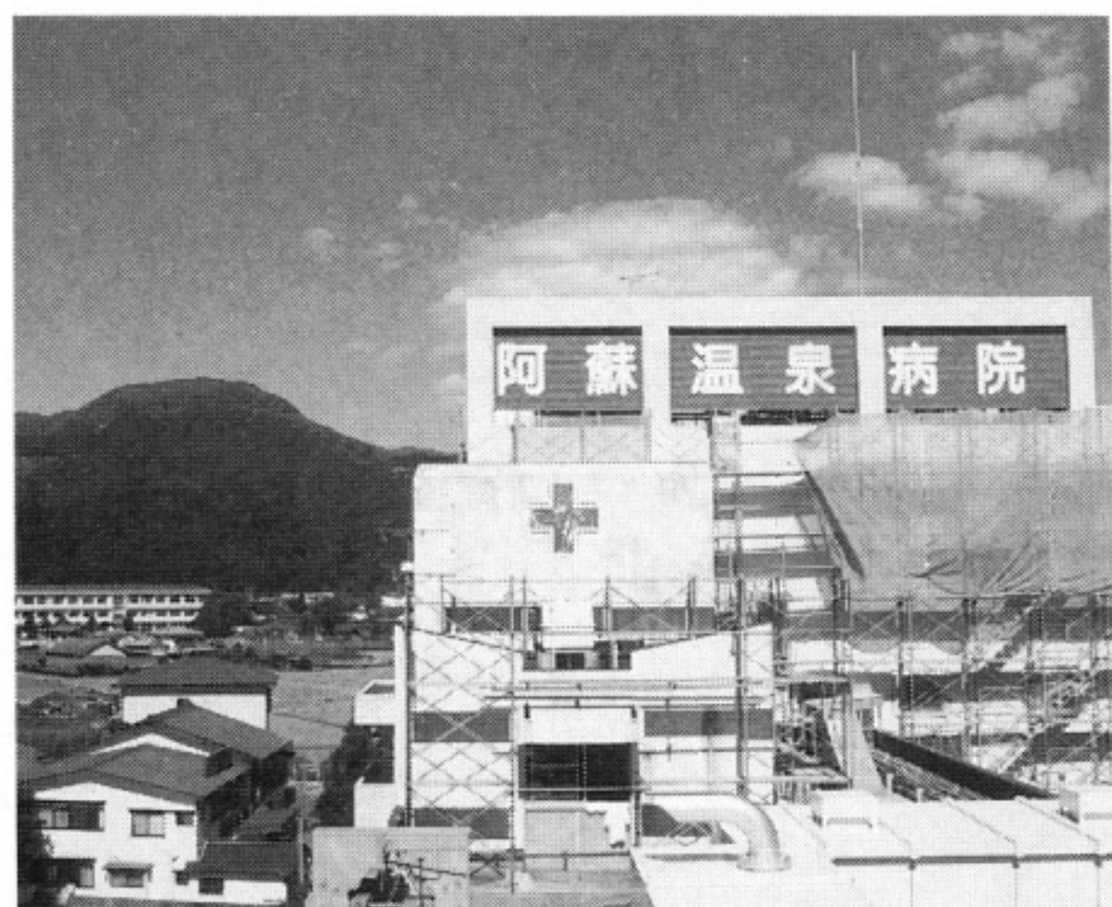
工事中の病院（背景に大観望をのぞむ）
