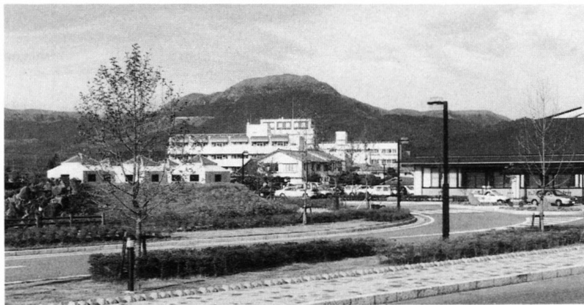
病棟遠景（阿蘇町保健福祉センターより病院を望む）
